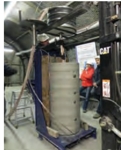
Konstrukce těsnícího systému sestaveného z osmi bentonitových bloků. Construction of a sealing system made up of eight bentonite blocks.
