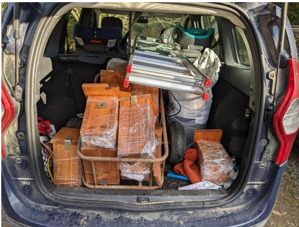
Příprava na instalaci budek
