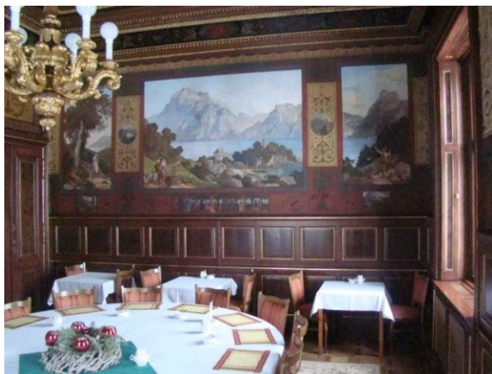
Nově fládrované obklady včetně navráceného původního zclacení.
