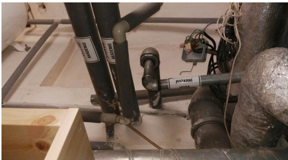
Vybudování dvou nových požárních vodovodů
