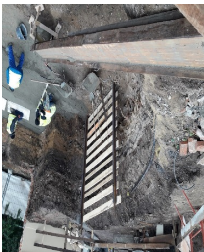
Zemní práce při budování nového vstupu s výtahem pro bezbariérový vstup
