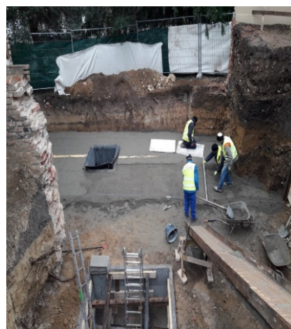
Zemní práce při budování nového vstupu s výtahem pro bezbariérový vstup
